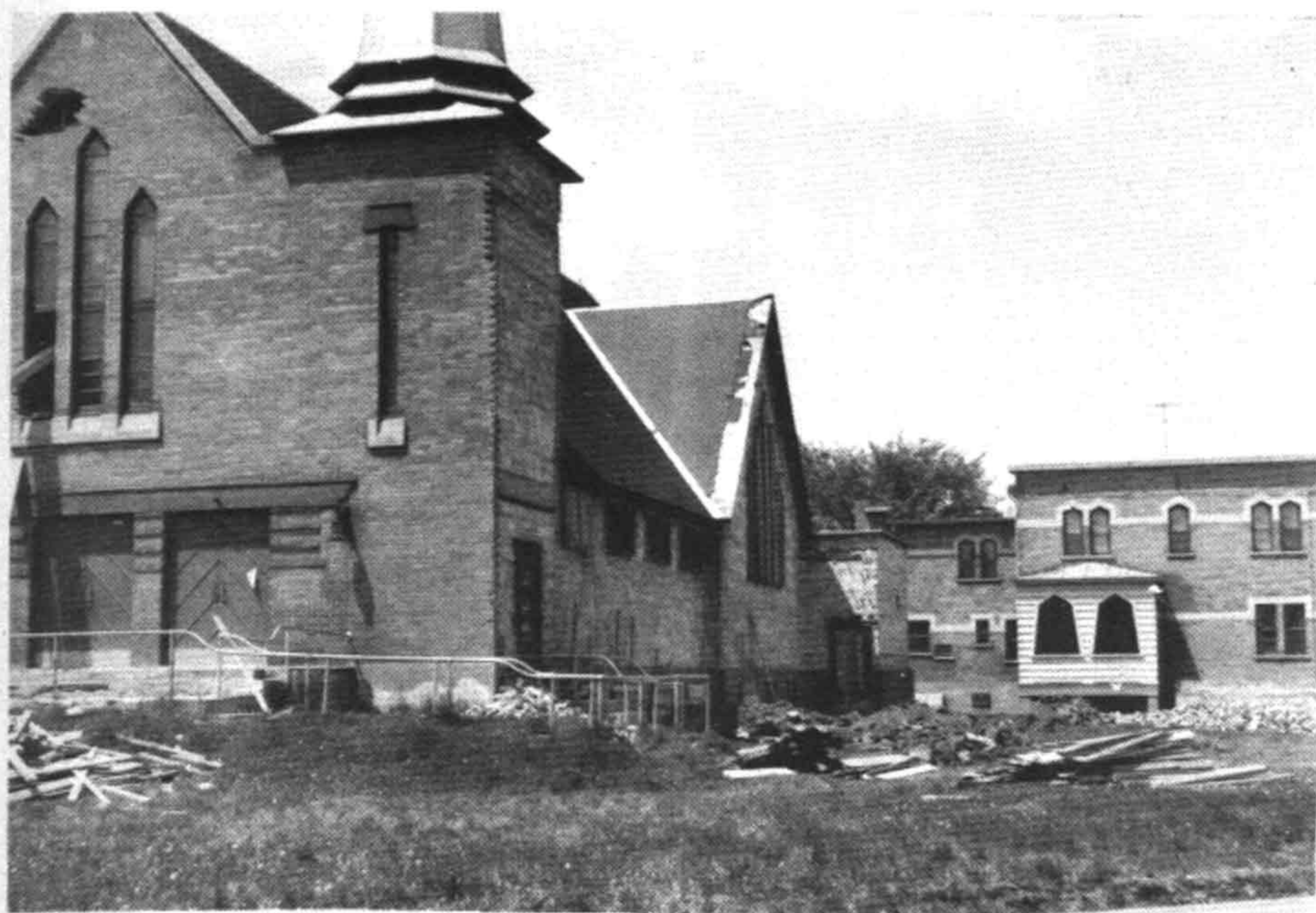
L' Eglise St-Georges de Montréal-Sud, telle que nous la voyons présentement durant les réparations d'agrandissement.
