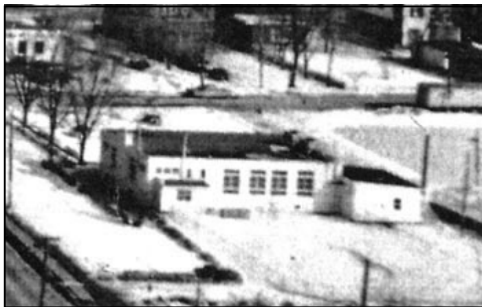
L'ancien chalet du parc Saint-Charles ou LRA .
