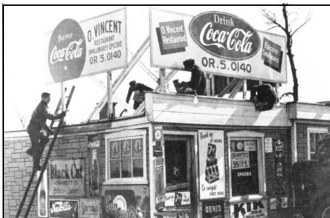
Aménagement du « petit Vincent » sur le chemin du Coteau Rouge (Sainte-Foy).
